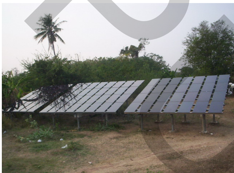
ภาพที่ 3.2 การติดตั้งใช้งานแผงเซลล์แสงอาทิตย์
