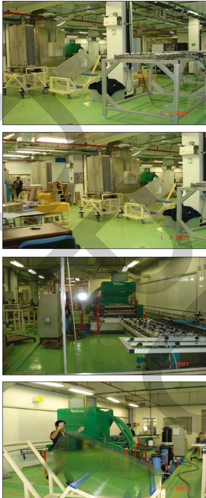
ภาพที่ 1.3 เครื่องจักรและพื้นที่การทำงานในโรงงานต้นแบบ
