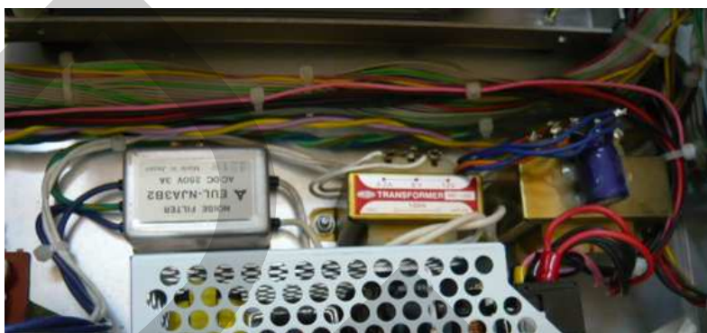
ภาพที่ 3.37 แสดงการจัดเก็บสายไฟเครื่อง Iron Core Caulking No.2
