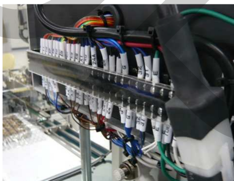
ภาพที่ 3.46 แสดงการจัดเก็บสายไฟเครื่อง Iron Core Caulking No.1
