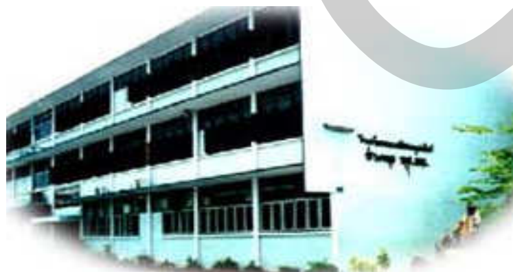
ภาพที่ 3.2 อาคารเรียน 3 ชั้น 12 ห้องเรียนก่อสร้างในปี พ.ศ. 2515
