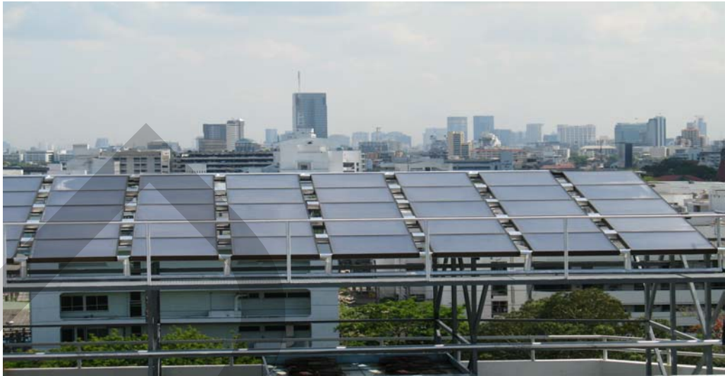
ภาพผนวกที่ ก4 แบบแสดงการติดตั้งแผงแสงอาทิตย์
