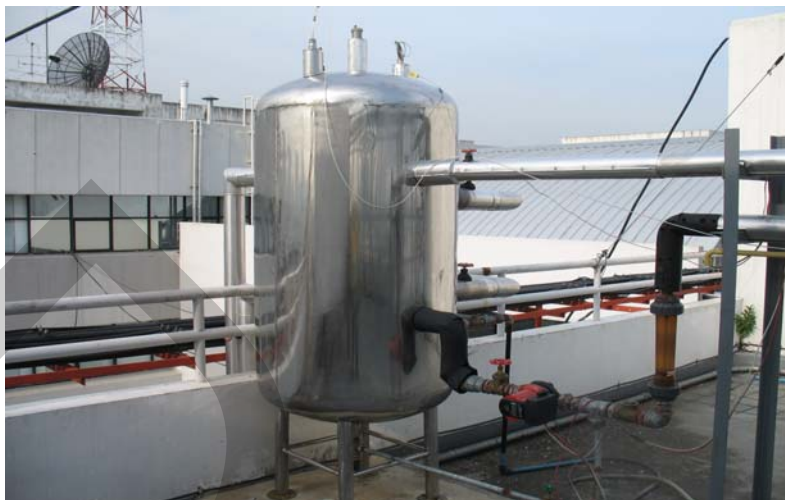
รูปที่ 3.12 ถังเก็บน้ำร้อน
