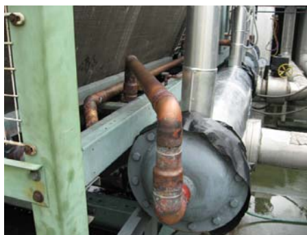
ภาพผนวกที่ 66 แบบแสดงการติดตั้งเครื่องแลกเปลี่ยนความร้อนกับ CHILLER
