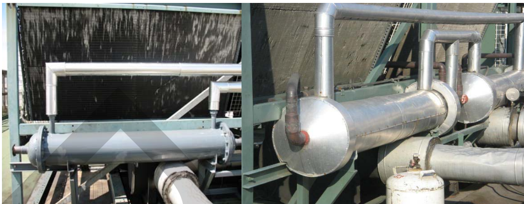
รูปที่ 3.11 อุปกรณ์แลกเปลี่ยนความร้อน
