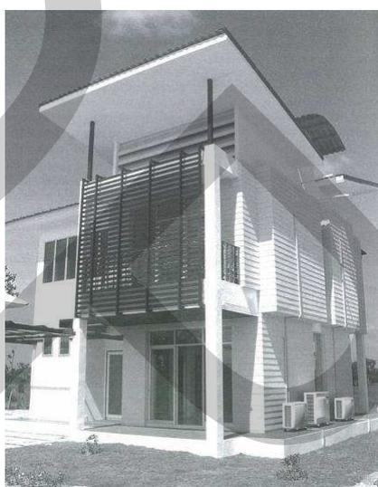
รูปที่ 3.7 บ้านเอมัย 10 ที่แยกหลังคาโลหะชั้นนอกออกจากหลังคา
