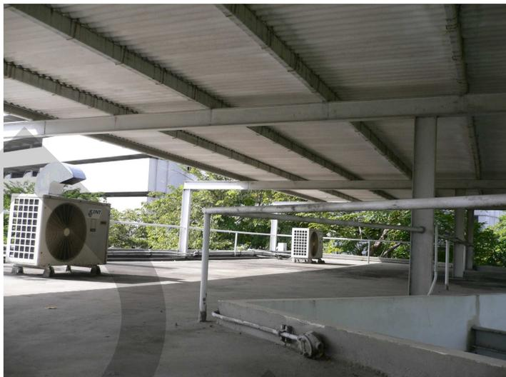
รูปที่ 4.12 คอมเพรสเซอร์เครื่องปรับอากาศที่วางไม่ได้รับความร้อนจากแสงแดดโดยตรง
