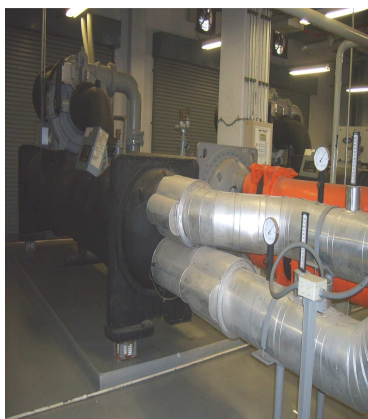
รูปที่ 3.31 ติดตั้งเครื่องทำน้ำเย็น (Chiller) ประสิทธิภาพสูง
