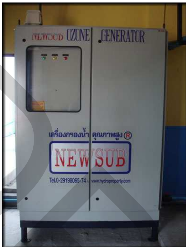
ภาพที่ 2.6 เครื่องฆ่าเชื้อโรคในน้ำด้วยก๊าซโอโซน (OZONE GENERATOR) ที่มา: www.hydroproperty.com
