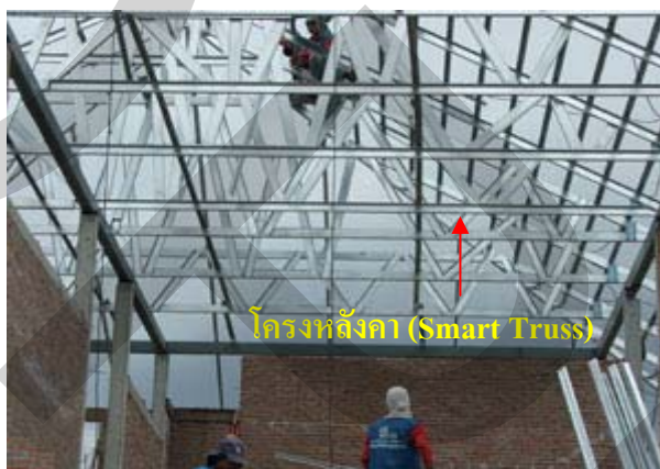
ภาพที่ 2.13 แสดงการติดตั้งโครงหลังคา (Smart Truss)
