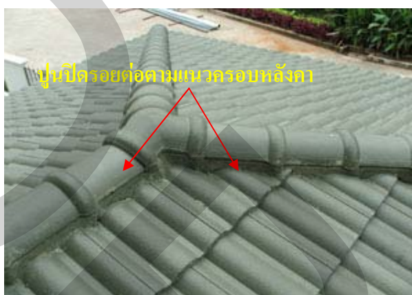
ภาพที่ 2.26 แสดงการป็นปูนปิดรอยต่อตามแนวกรอบหลังคา
