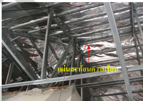
ภาพที่ 2.19 แสดงการติดตั้งแผ่นสะท้อนความร้อนใต้แป
