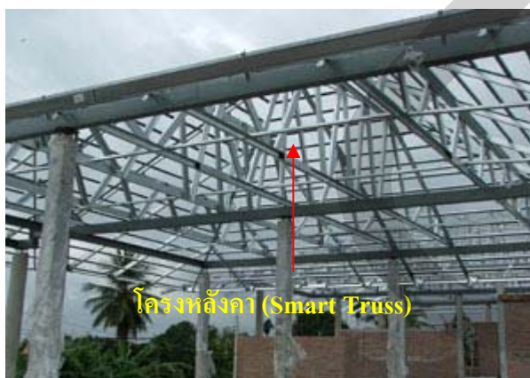
ภาพที่ 2.6 โครงหลังคา (Smart Truss)
