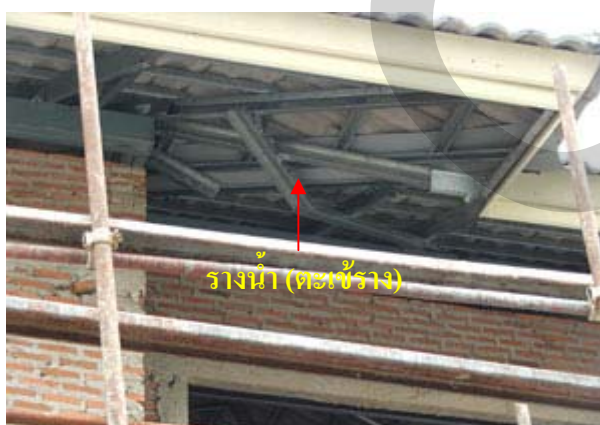
ภาพที่ 2.18 แสดงการติดตั้งวัสดุที่ใช้ทำรางน้ำ (ตะเข้ราง)
