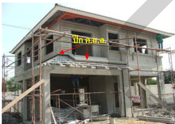
ภาพที่ 2.25 แสดงการเทปีก ค.ส.ล ปัดรอยต่อระหว่างกระเบื้องซีแพคโมเนียกับแนวผนังก่ออิฐฉาบปูน
