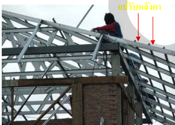
ภาพที่ 2.15 แสดงการติดตั้งและจัดระยะห่างของแปรับหลังคา
