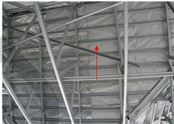
ภาพที่ 2.20 แสดงการติดตั้งแผ่นรองกันรั่วได้เป
