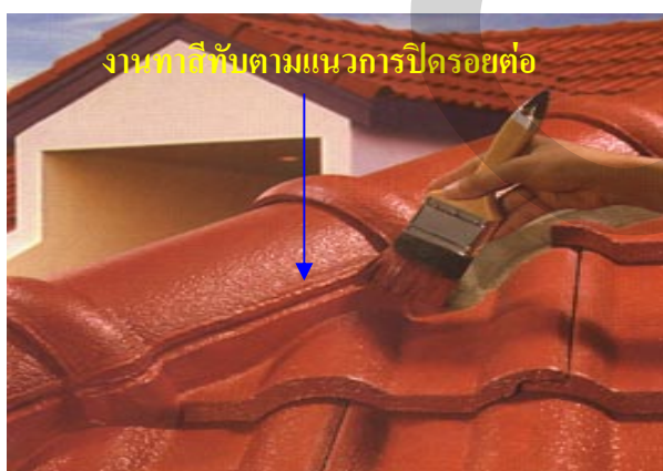
ภาพที่ 2.27 แสดงการทาสีทับตามแนวการปิดรอยต่อระหว่างกรอบหลังคา กับแนวของการมุงกระเบื้อง
