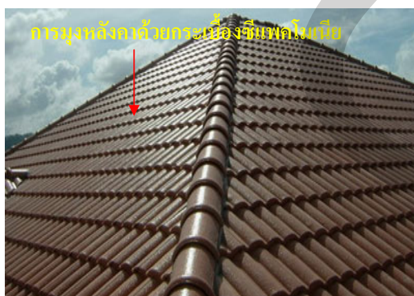
ภาพที่ 2.22 แสดงการมุงหลังคาด้วยกระเบื้องซีแพค โมเนีย
