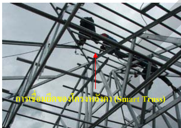
ภาพที่ 2.7 แสดงระบบการเชื่อมยึดด้วยนอตสกรูของโครงหลังคา (Smart Truss)
