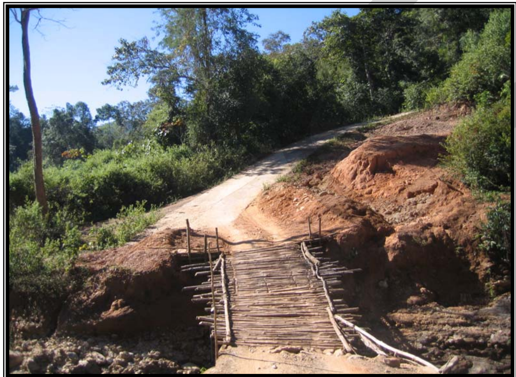
ภาพที่ 3.7 แสดงบริเวณถนนทางเข้าที่ก่อสร้างโครงการ
