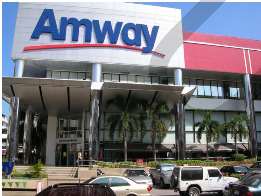
ภาพที่ 3.5 สภาพภายนอกอาคารแอมเวย์
