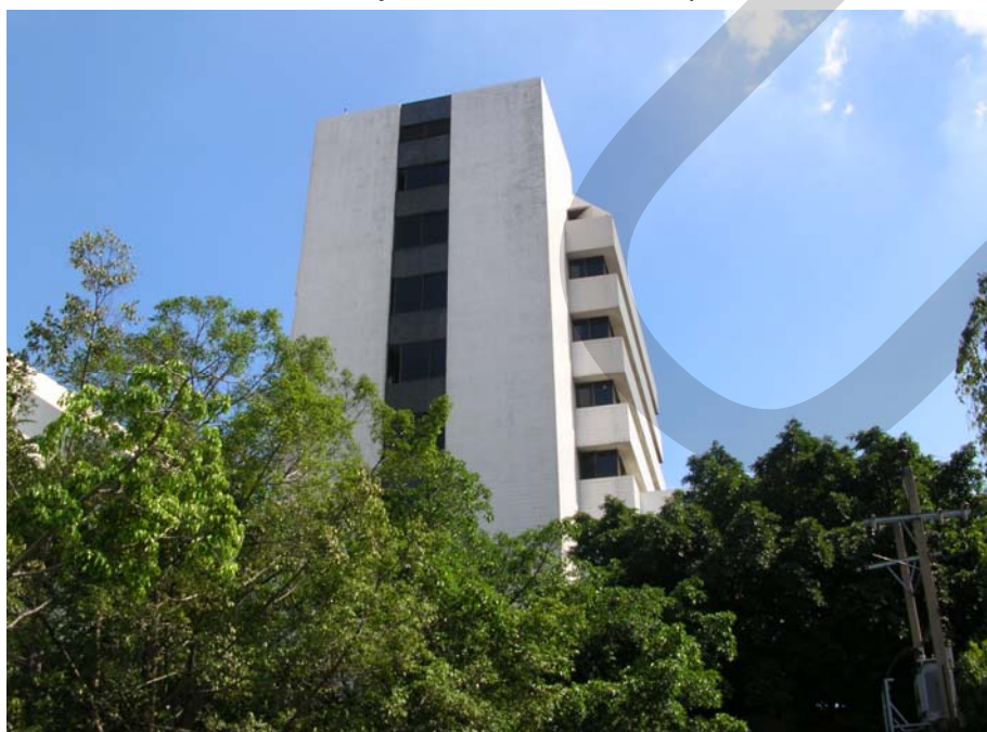
ภาพที่ 3.3 สภาพภายนอกอาคารโตโยต้าหัวหมาก
