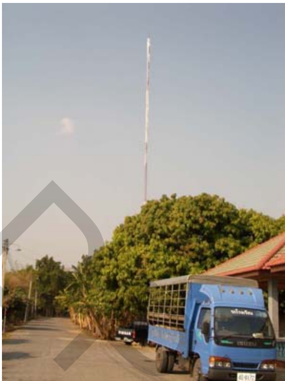
ภาพที่ 13 เสาอากาศของสถานีวิทยุเสียงชุมชนกาญจนบุรี
