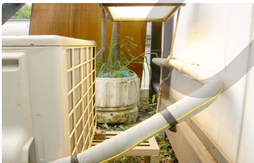
ภาพที่ 3.21 การติดตั้งห้องชุด Condenser ที่ไม่สามารถระบายความร้อนได้
