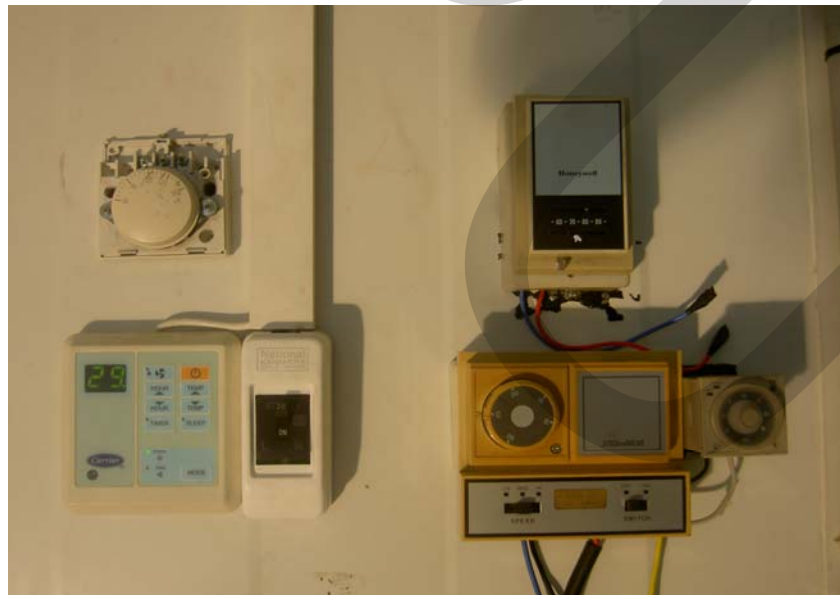
ภาพที่ 3.19 การติดตั้งเทอร์โมสตัดแบบ Bimetal
