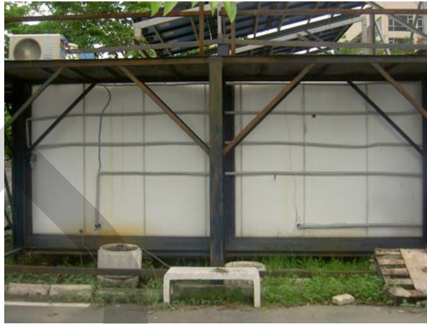
ภาพที่ 3.15 การติดตั้งเครื่องปรับอากาศที่ไม่ถูกต้อง ท่อสารทำความเย็นยาว, ชุด CDU สูงกว่า ชุด FCU,ชุด CDU ตากแดด
