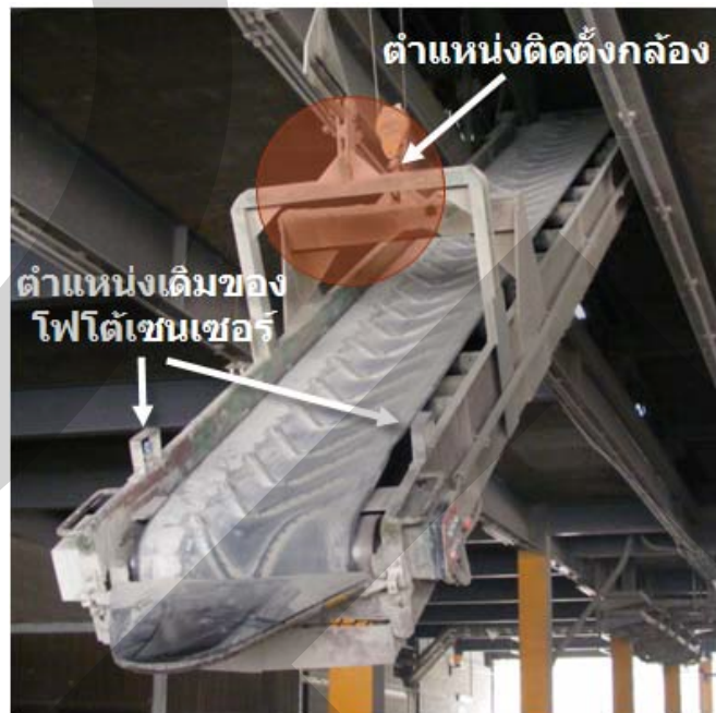
ภาพที่ 3.6 แสดงตำแหน่งติดตั้งชุดกล้องดิจิทัลรับภาพที่ปลายรางสายพาน
