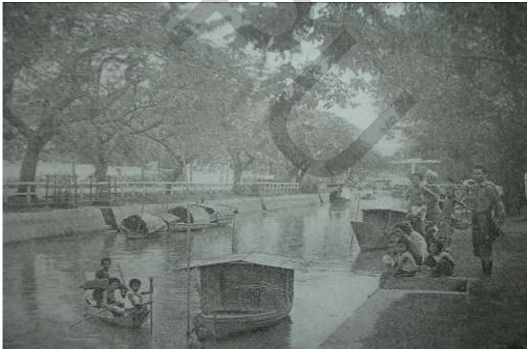
คลองลอดตรงบริเวณวังสราญรมย์สมัยรัชกาลที่ 5 ลักษณะทั่วไปสามารถเทียบเคียงกับคลองเปรมประชากรช่วงต้นสาย ในยุคหลังเปิดใช้คลองใหม่ๆ ได้ (ภาพจาก อเนก นาวิกมูล, หนังสือสมุดภาพ, กรุงเทพฯ, 2545)
