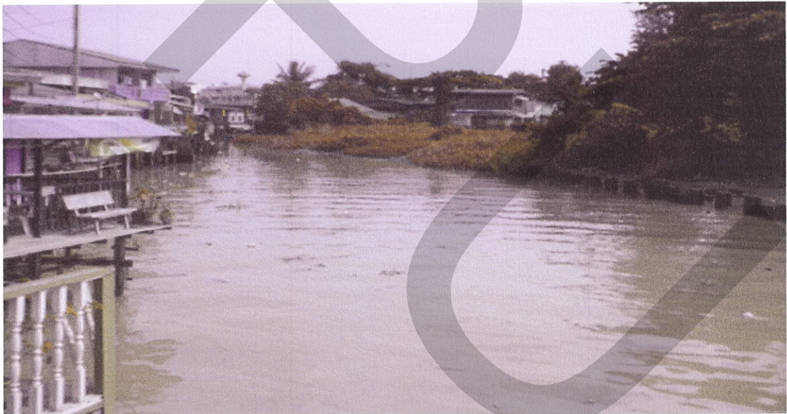
ปากทางเข้าคลองบางเขนเก่าจากแม่น้ำเจ้าพระยาในปัจจุบัน
