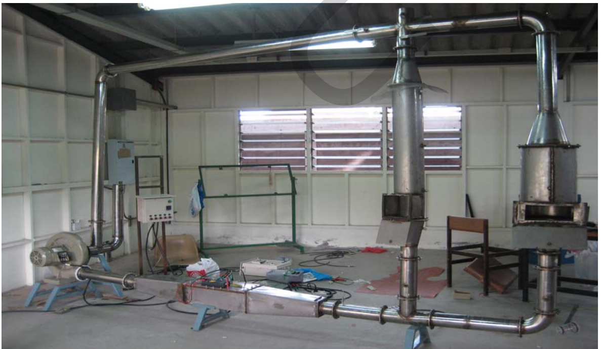
ภาพที่ ค.20 การติดตั้งตัวเครื่องห้องอบแห้งภายในห้องปฏิบัติงานโครงการ
