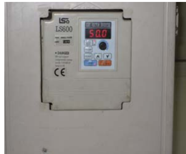
ภาพที่ ๗.8 ตู้ควบคุม Inverter
