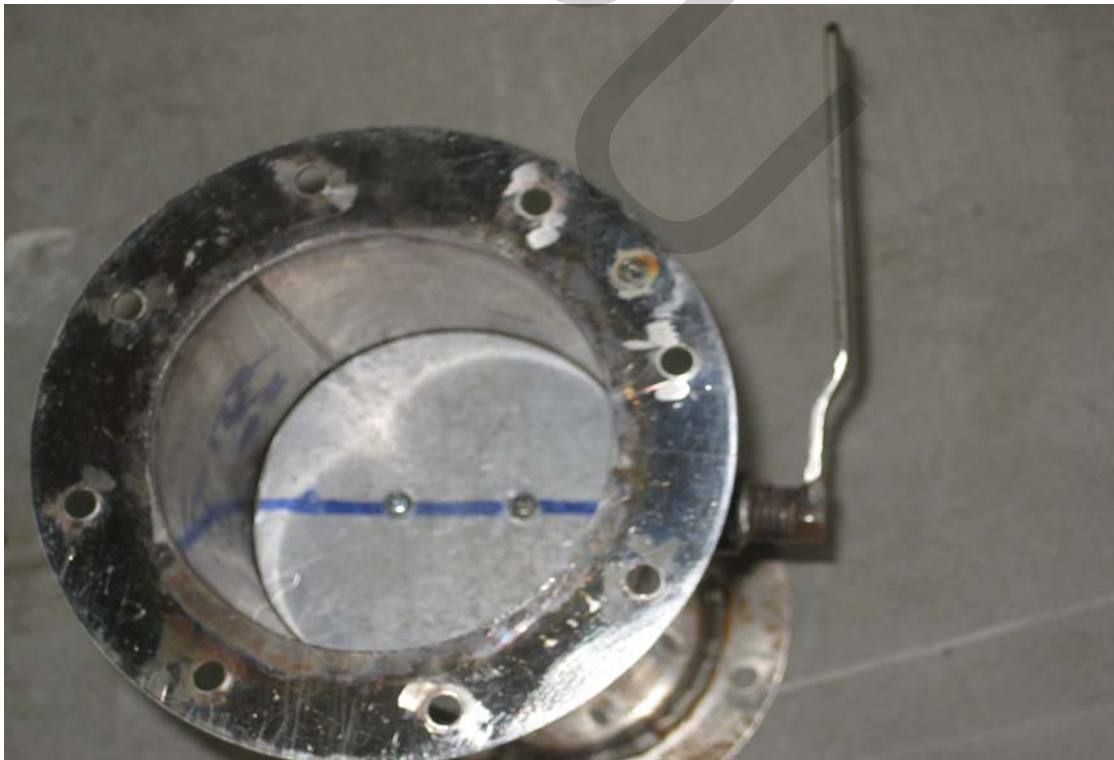
ภาพที่ ค.12 วาล์วเปิด-ปิดภายในท่อของห้องอบแห้ง
