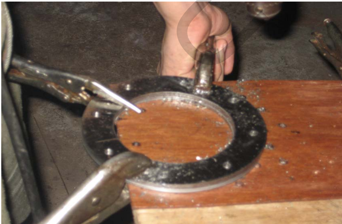
ภาพที่ ค.8 หน้าแปลนที่เจาะรูเสร็จแล้ว
