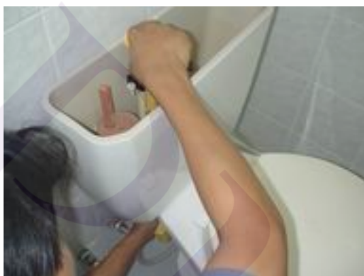
ภาพที่ 3-17 การใช้เครื่องมือใหม่ที่พัฒนาขึ้นยึดหัวสกรูในถังน้ำ
