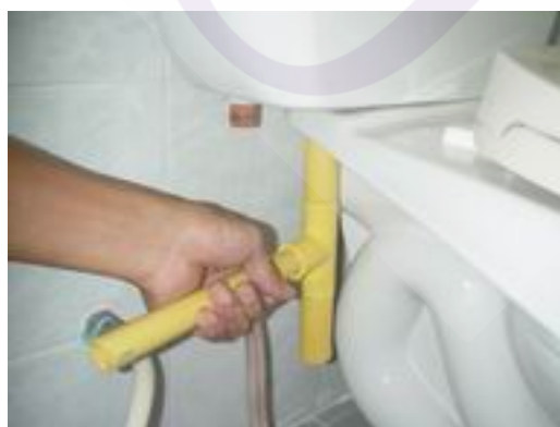
ภาพที่ 3-11 การใช้เครื่องมือใหม่ที่สร้างขึ้นถอดน็อตยึดถึงน้ำ
