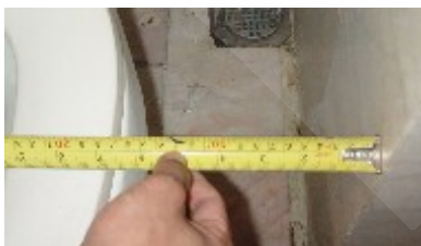
ภาพที่ 3-32 พื้นที่ว่างระหว่างโถสุขภัณฑ์กับผนังห้องน้ำของพื้นที่ที่ไม่สะดวกในการทำงาน ซึ่งพื้นที่ว่างรอบโถสุขภัณฑ์ ของอาคาร ลามซอง 24 ดังแสดงในภาพที่ 3-33
