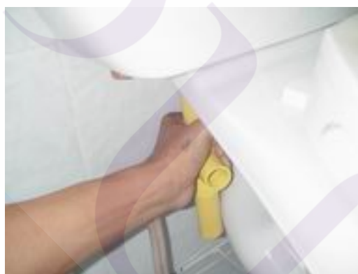
ภาพที่ 3-13 การใช้เครื่องมือใหม่ที่พัฒนาขึ้นถอดน็อตยึดถึงน้ำ
