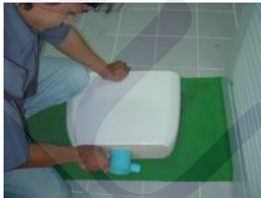
ภาพที่ 3-21 การใช้เครื่องมือใหม่ที่พัฒนาขึ้นไขน็อต
