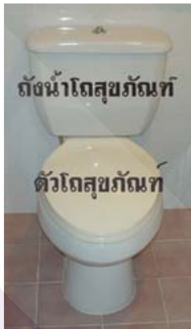
ภาพที่ 3-1 โถสุขภัณฑ์ประกอบด้วยตัวโถสุขภัณฑ์และถังน้ำโถสุขภัณฑ์
