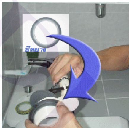
ภาพที่ 3-34 ซีลยางในชุดอุปกรณ์ว่าล่วน้ำลงในถังน้ำโถสุขภัณฑ์
