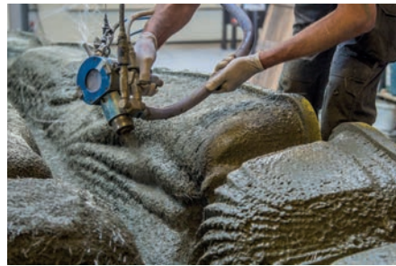
4 คอนกรีตเสริมใยแก้วที่ฉีดพ่นบนแม่พิมพ์สามมิติซ้ำกันหลายชั้น
